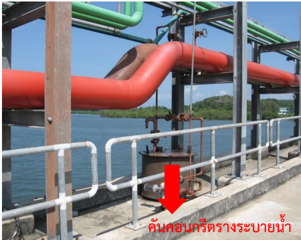
รูปที่ ข.1-4 คั่นคอนกรีตสูง 15 เซนติเมตร ขนานไปกับแนวท่อบนสะพานท่าเทียบเรือ และบ่อพักน้ำที่รวบรวมน้ำฝนปนเปื้อนน้ำมัน
