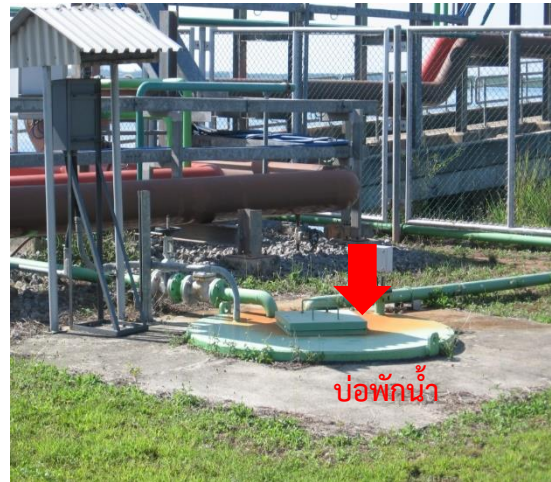
รูปที่ ข.1-4 คั่นคอนกรีตสูง 15 เซนติเมตร ขนานไปกับแนวท่อบนสะพานท่าเทียบเรือ และบ่อพักน้ำที่รวบรวมน้ำฝนปนเปื้อนน้ำมัน
